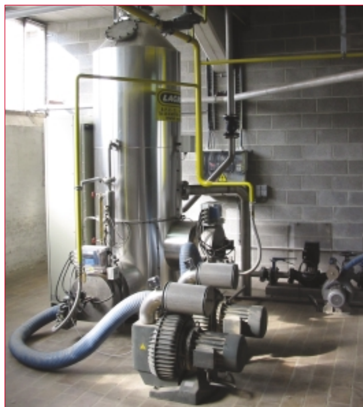
Le générateur est conçu pour garantir la production en continu de 15m 3 /h d'eau chaude à 70°C.
